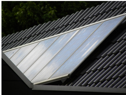
Enkele nu al aanwezige zonnepanelen op het dak van het gemeentehuis
