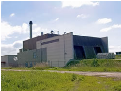
Houtgestookte warmte-krachtkoppelingsinstallatie in Lelystad
